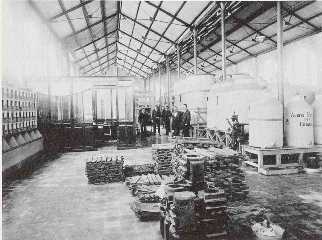
Vista interior del Almacén de las obras
