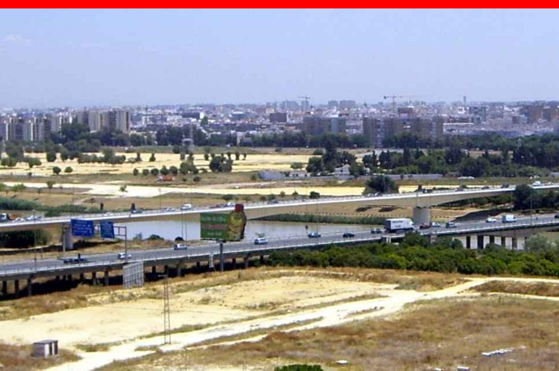
Puentes del Rey Juan Carlos I (1981) y de la Reina Sofía (1991)
