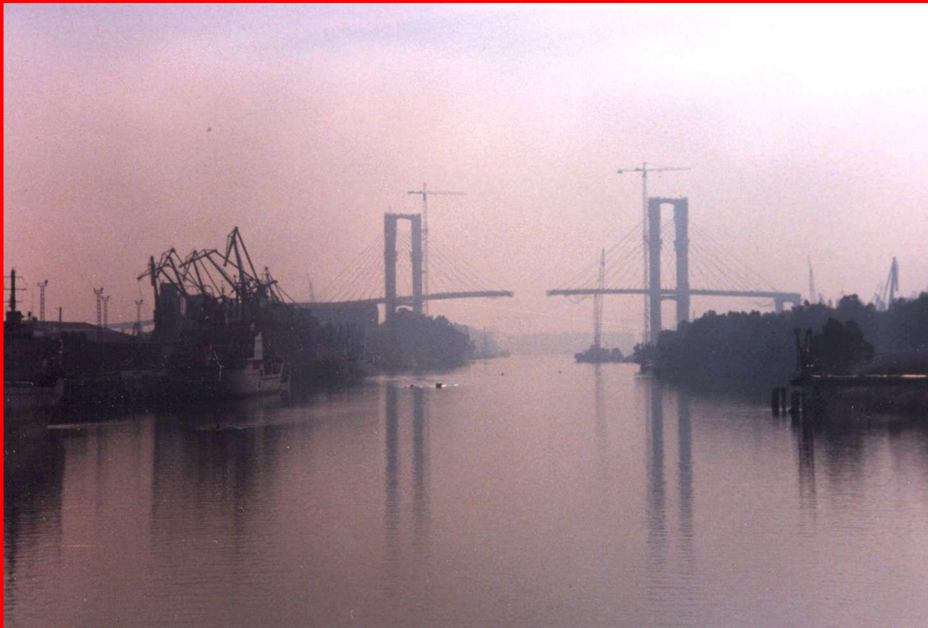
El puente del V Centenario, en construcción en 1990
